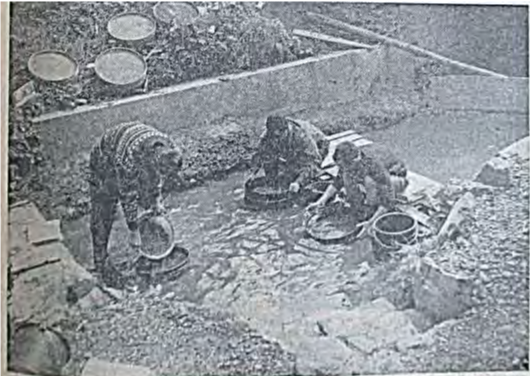
Bild 8: Die Schlammmanlage in der Netze
