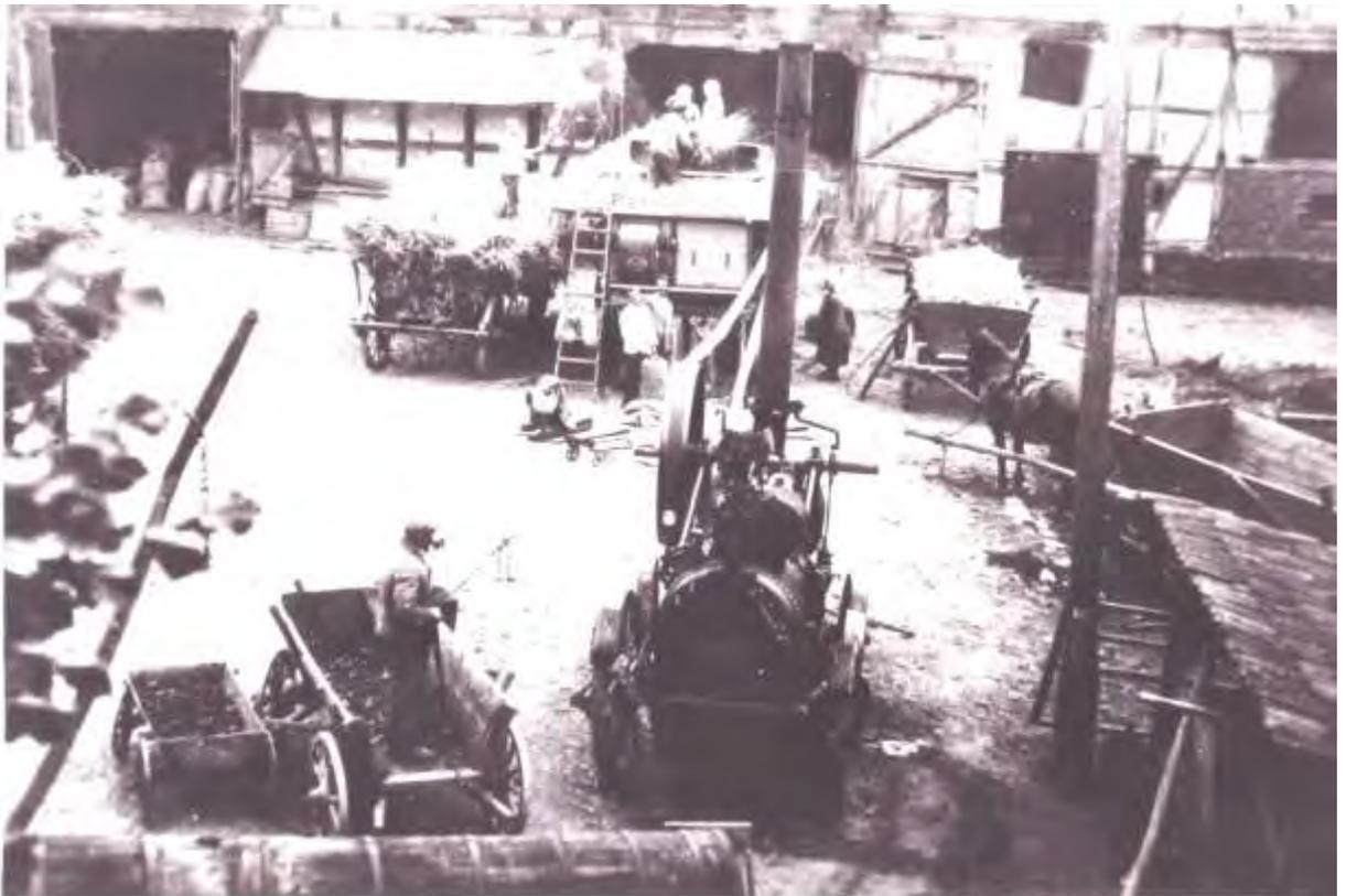
Der Lohnunternehmer Karl Frese betrieb ab ca. 1885 zwei der ersten fahrbaren Dampfmaschinen in Waldeck. Angetrieben wurden eine Schrotmühle, eine Säge und die zwei Dreschmaschinen.
