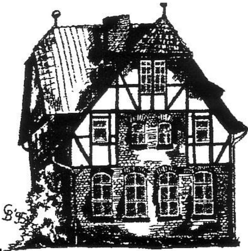
Grube aus Höringhausen.
